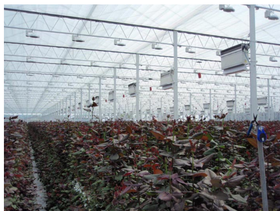
図5 バラの半閉鎖型ハウス、柱の横に設置されて機器が空調用の熱交換器
